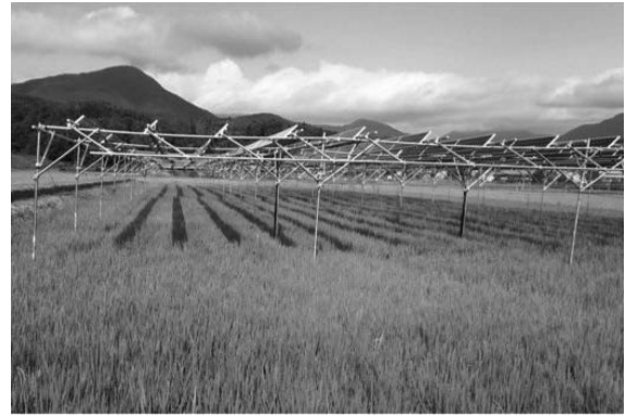
写真1 最初の実証設備
