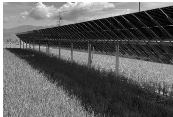
写真6 T字型構造の6号架台
