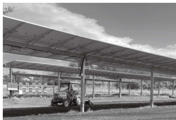
写真 7 営農への影響を最小化した設置例
