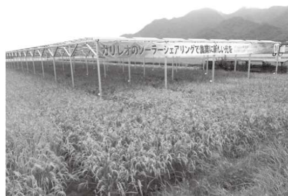
写真3 3号機の設置状況
