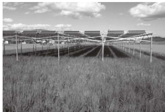
写真2 2号機の設置状況
