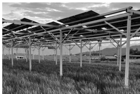
写真5 大面積の太陽光パネルを設置した5号架台
